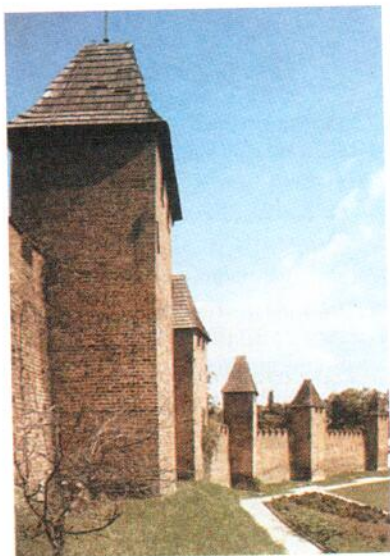
◀ Obr. 50 Hradby města Nymburka – nynější stav
